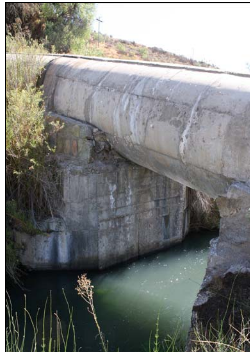
Ducto de concreto cercano al sitio.
