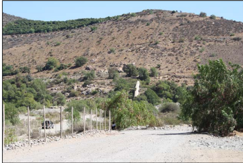
Vista general del sector, desde el camino de acceso.
